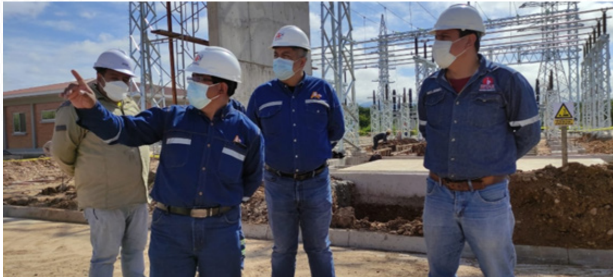
AETN inspecciona subestación Bermejo, Tarija
